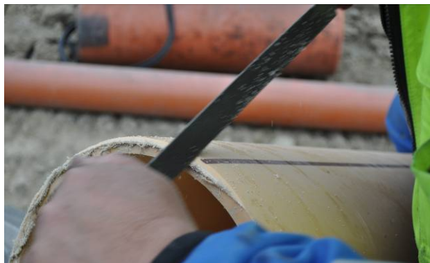
Bild 14: Anfasen des Kunststoffrohres, reinigen und einschmieren
