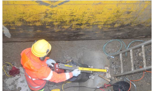
Bild 6: Korrekt montiertes Kernbohrgerät
