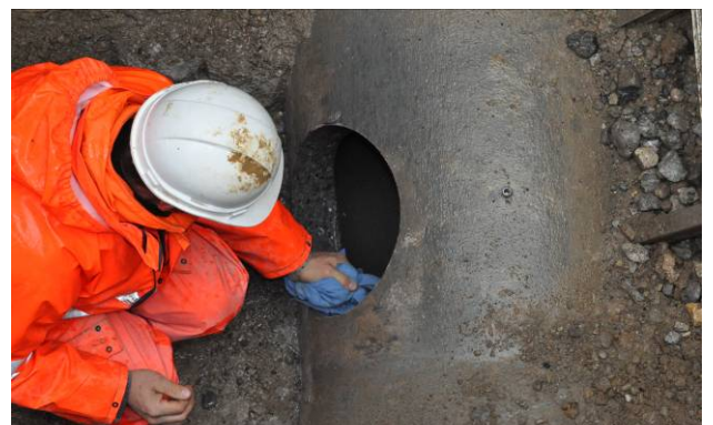
Bild 7: Bohrloch reinigen
