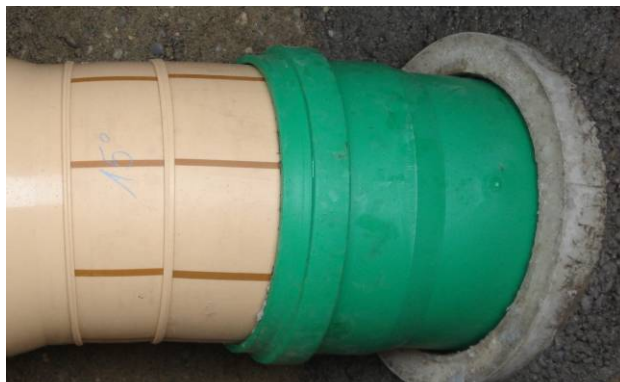
Bild 15: Angeschlossenes Anschlussrohr
