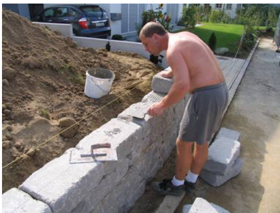
Bild 38: Mörteln der Fugen
