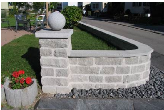
Bild 44: Versetzte SANTURO® Abdeckplatten in Segmente geschnitten
