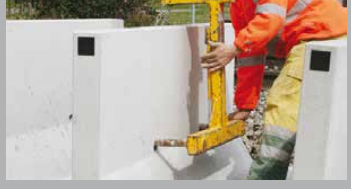
VERSETZGERÄTE FÜR PERRONWINKEL
