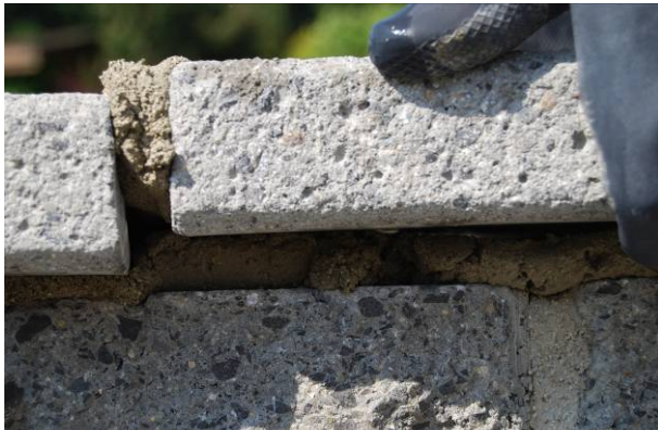
Bild 63: Versetzen der Abdeckplatten
