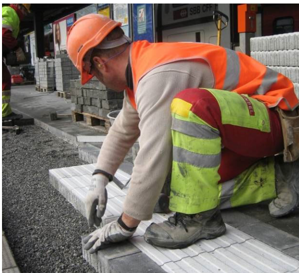
Bild 36: Verlegen der CARENA® Sicherheitsliniensteine H = 8 cm
