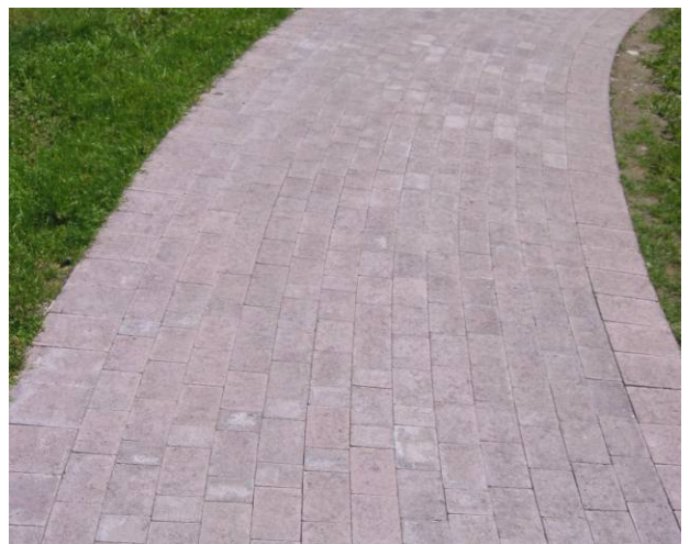
Bild 3: TEGULA® Pflastersteine porphyr, vollkantig
