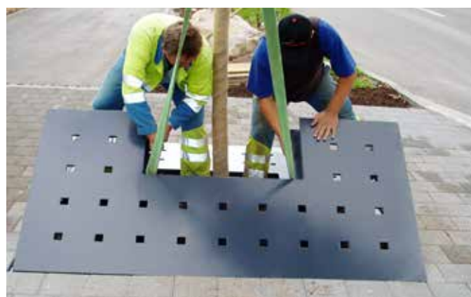
Versetzen der COPAL STEEL Stahlbaumscheibe
