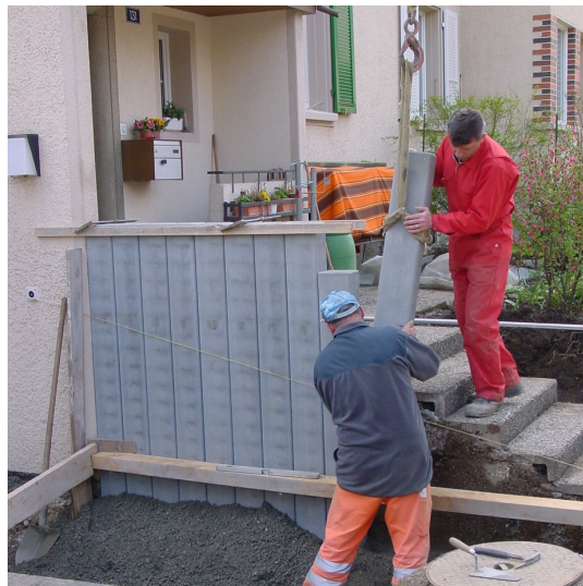
Bild 12: Einbau Palisaden
