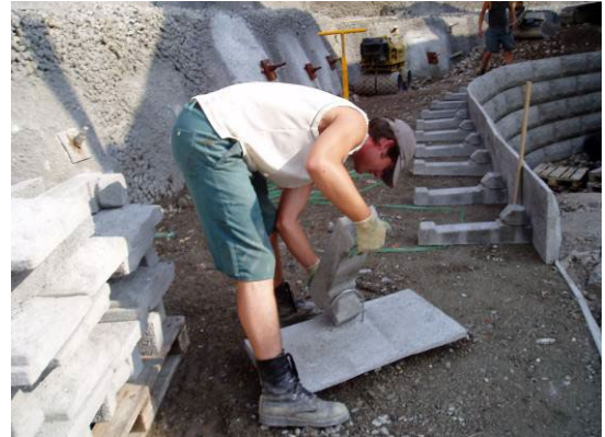
Bild 15: Frontplatte mit Anker verbinden
