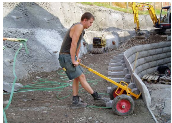
Bild 17: LOCK+LOAD Versetzwagen
