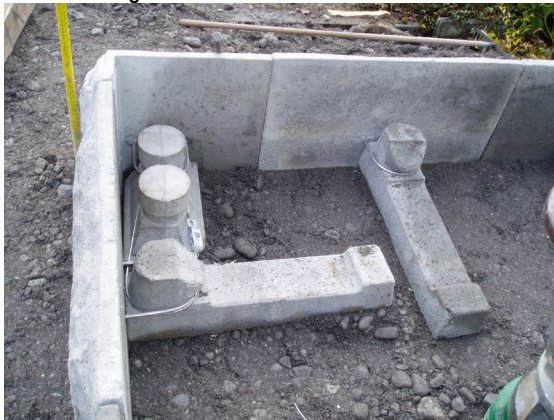
Bild 39: Eckstein mit Eckanker und -spanner
