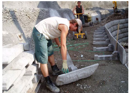
Bild 16: Frontplatte mit Anker verbinden
