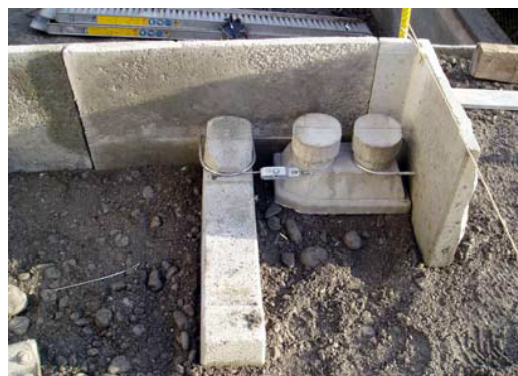
Bild 26a: Eckspanner parallel zum kleineren Schenkel montieren
