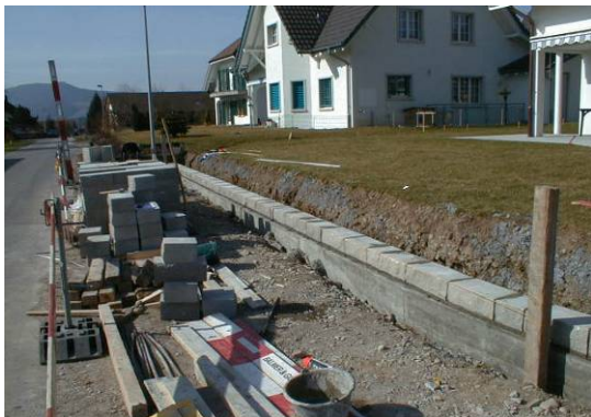
Bild 23: Versetzte erste Steinreihe in Betonfundament
