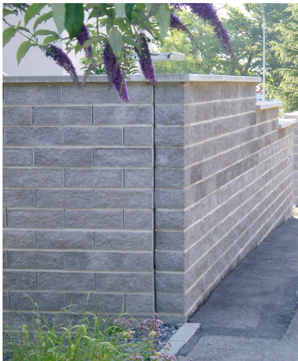
Bild 15: Dilatationsfuge (Produktneutral)
