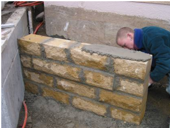
Bild 42 Aufbringen Mörtel für Abdeckplatte
