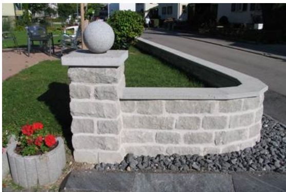
Bild 44: Versetzte SANTURO® Abdeckplatten in Segmente geschnitten
