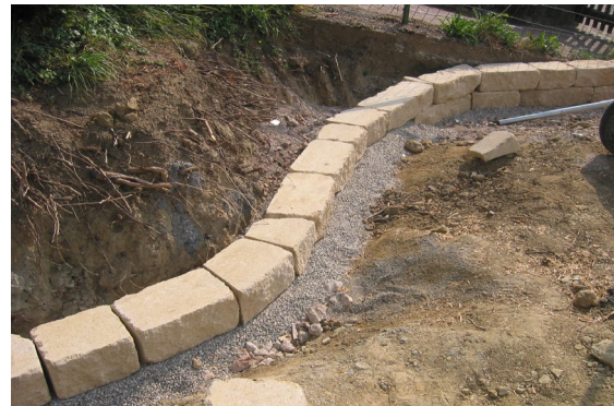
Bild 24: Versetzte erste Steinreihe in Kiesfundament
