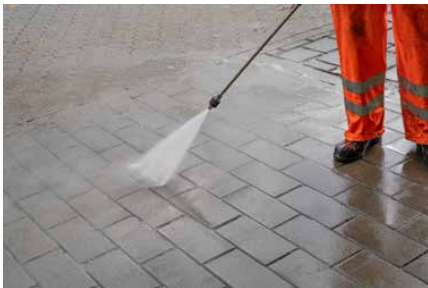
Hochdruckreiner mit ausreichendem Abstand einsetzen.
