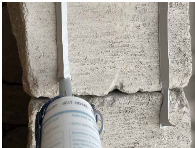
Bild 3: Korrekte Ausrichtung der Düse
