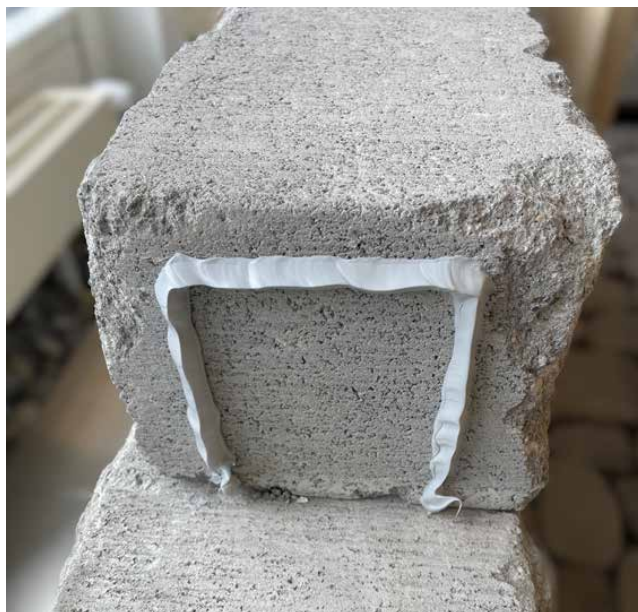
Bild 2: Verkleben und Abdichten der Stossflächen
