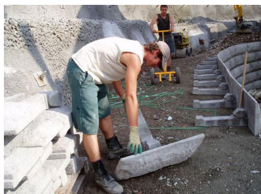
Bild 16: Frontplatte mit Anker verbinden
