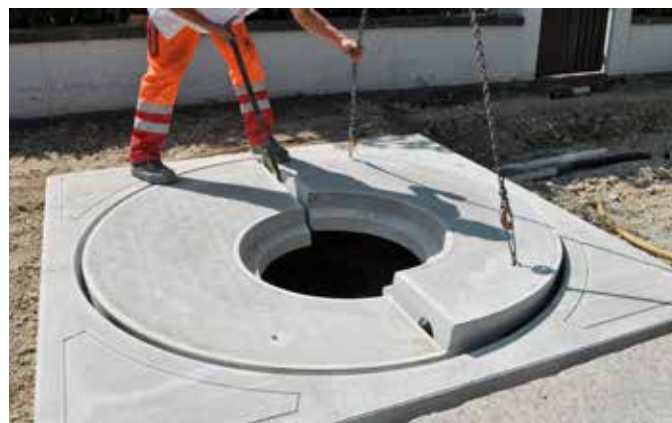
Versetzen der COPAL Betonabdeckung
