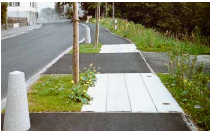
Wurzelbrücke mit Wehrsteinen als Anfahrtschutz
