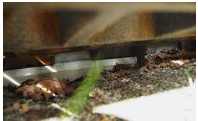
Genügender Zwischenraum unter der Abdeckung
