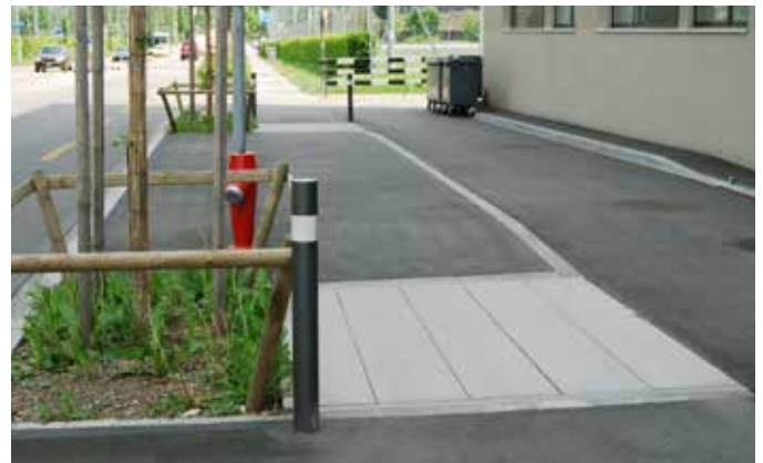
Einbau von Wurzelbrücken seitlich der Baumgrube
