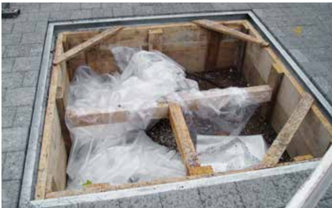
Eingebauter Stahlrahmen als Baumkranz
