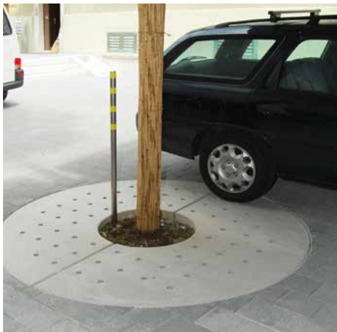
TREETUB Baumwurzelraumschutz mit Betonabdeckung
