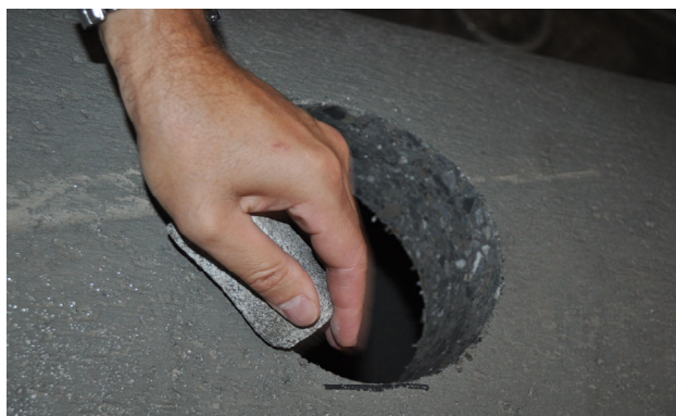
Bild 7: Bohrlochkante abrunden und Bohrloch reinigen
