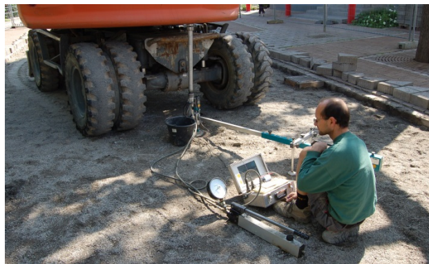
Bild 13: Kontrolle der Tragfähigkeit mit Me-Messungen
