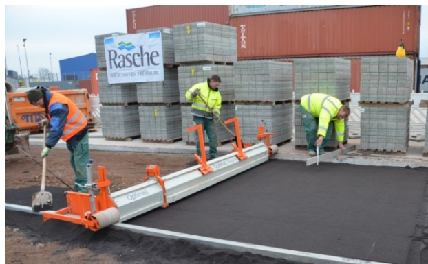
Bild 19: Mischgut abziehen
