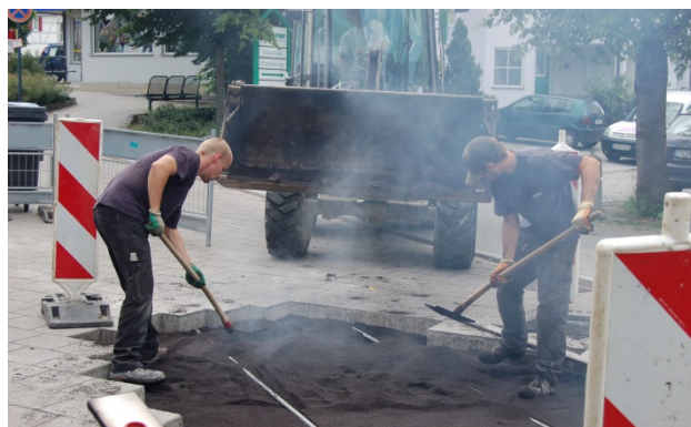
Bild 17: Mischgut muss gesetzt werden
