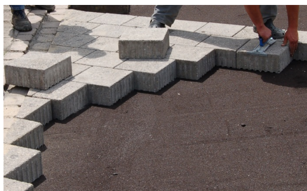
Bild 26: Verlegen von Hand
