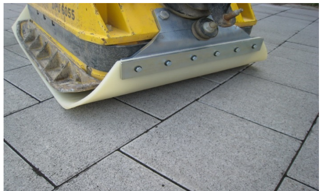
Bild 29: Abrütteln der Pflasterdecke
