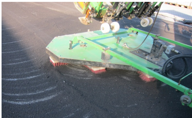
Bild 27: Maschinelles Einbringen des ECOPREC®-Fugenmaterials
