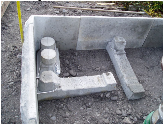
Bild 39: Eckstein mit Eckanker und -spanner
