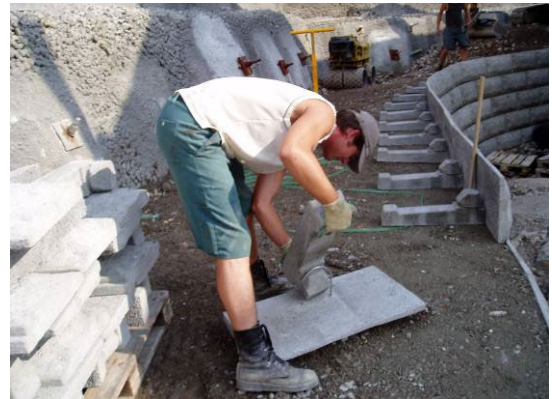
Bild 15: Frontplatte mit Anker verbinden
