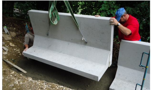
Bild 25: Versetzen der Winkelplatte auf ein Streifenfundament
