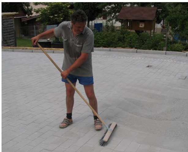
Bild 37: Einsanden der Fugen
