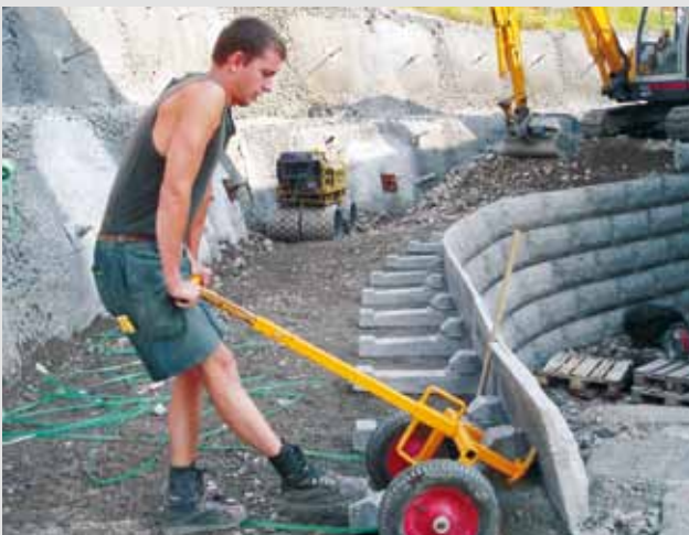
Einfaches Versetzen mit Handwagen
