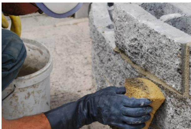
Bild 58: Ausbildung der Mörtelfugen und Reinigung der Mauersteine
