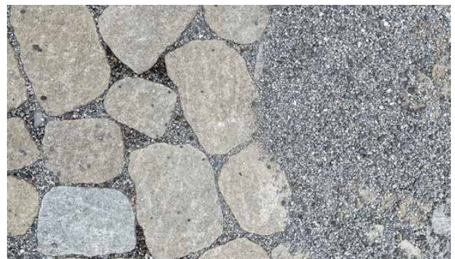
Einsanden/Einsplitten der Fugen
