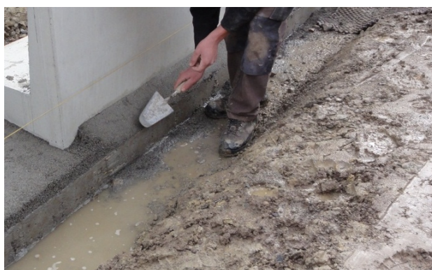
Bild 30: Erstellen der Fundamentnocken
