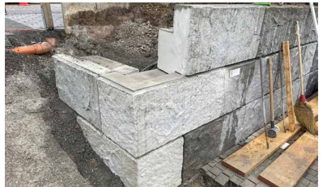
Bild 24 Versetzen der Eckelemente
