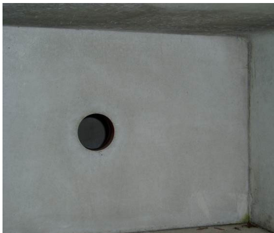
Bild 5: Lichtschacht mit Boden
