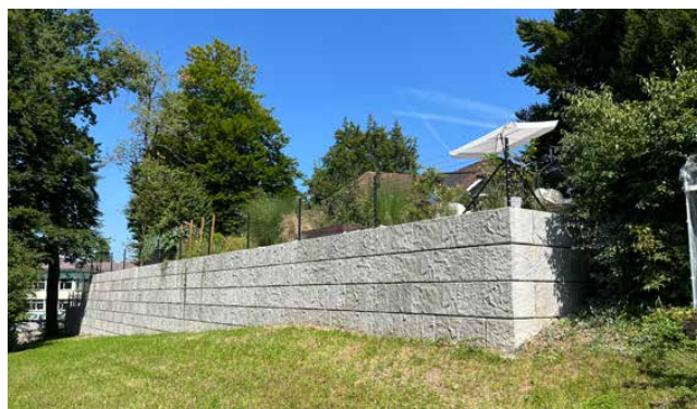
Bild 26 Geländer auf Mauerkrone
