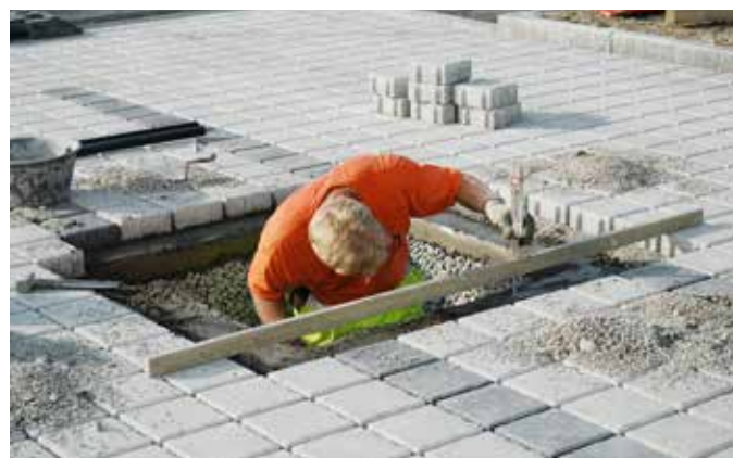
Erstellen eines Auflagers auf Fundamentrahmen
