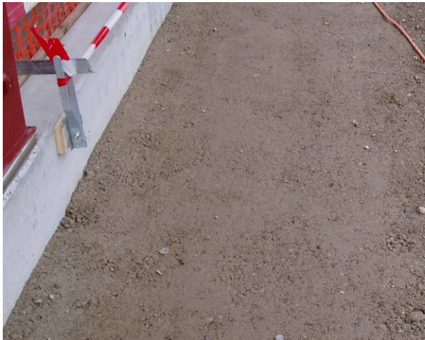
Bild 32: Eingebaute verdichtete Fundationsschicht
