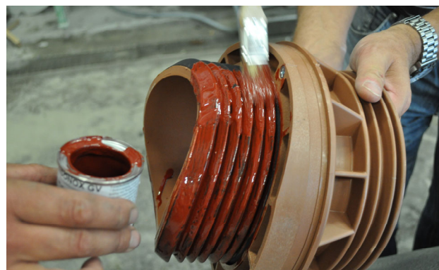
Bild 9: Auftragen von DENSONOX GV auf Dichtungsmanschette
