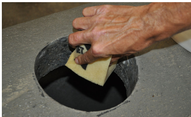
Bild 8: Bohrlochwandung mit Wasser befeuchten
