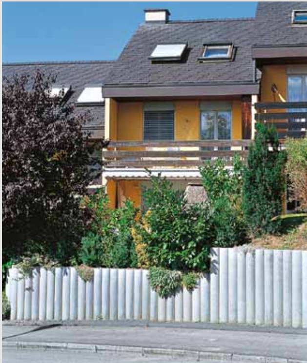
Beton-Palisaden als Hangsicherung.
