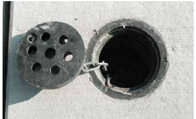
Belüftungs- und Bewässerungsstutzen
