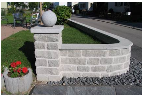
Bild 44: Versetzte SANTURO® Abdeckplatten in Segmente geschnitten
