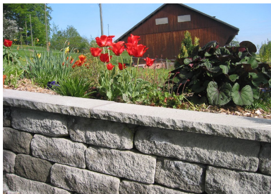
Bild 43: Versetzte SANTURO® Abdeckplatten
