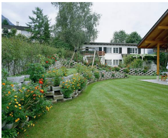
Bild 30: VERDURO® Böschungsmauer bepflanzt
