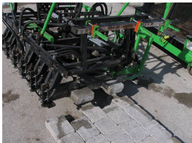
Bild 39: Maschinelle Verlegung mit OPTIMAS Verlegemaschine
