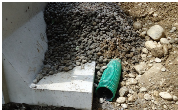
Bild 28: Einbau einer Sickerleitung mit Sickerpackung
