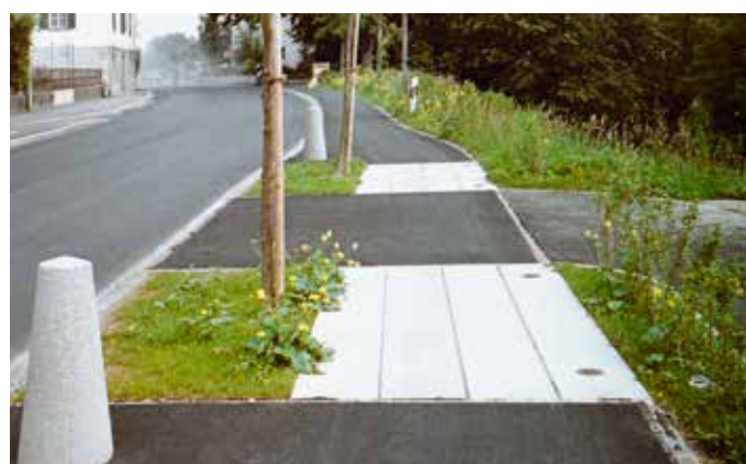
Wurzelbrücke mit Wehrsteinen als Anfahrtschutz
