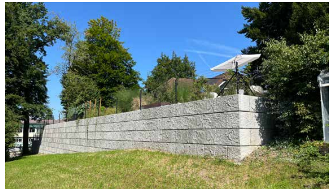
Bild 26 Geländer auf Mauerkrone
