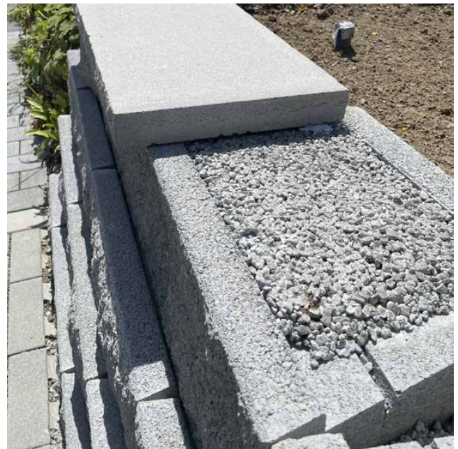
Bild 19: Versetzen von Abdeckplatten
