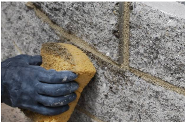
Bild 48: Aufräumen der Fugenfüllung und reinigen der Bausteine
