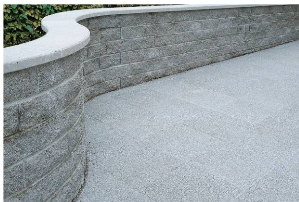
Bild 3: Mauer mit Radiusspaltsteinen
