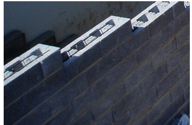
Bild 49: Bewehrungseinlagen, eingelegt in die vorgesehene Nuten
