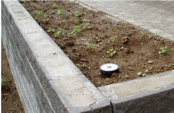
Bild 61: Vorbereitete Mauerkrone
