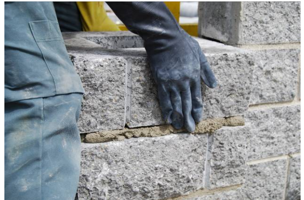
Bild 59: Versetzen von Pfeilerspaltsteinen
