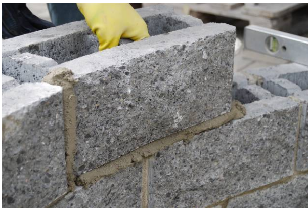
Bild 57: Versetzen von Radiussteinen
