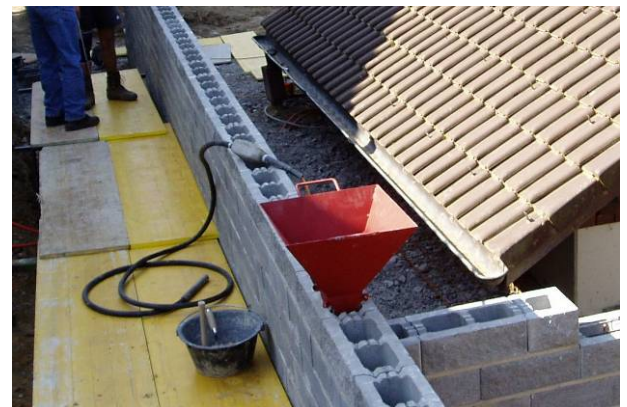
Bild 50: Einbringen von Füllbeton mit einem geeigneten Trichter
