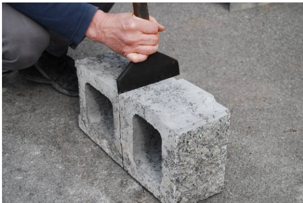
Bild 53: Trennen der Spaltsteine mit Meissel
