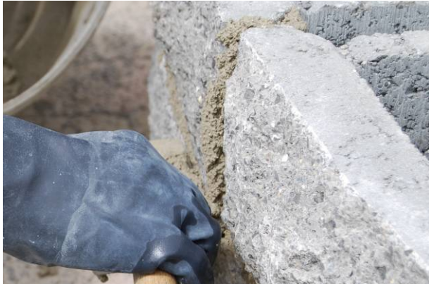
Bild 46: Modellieren der Fuge
