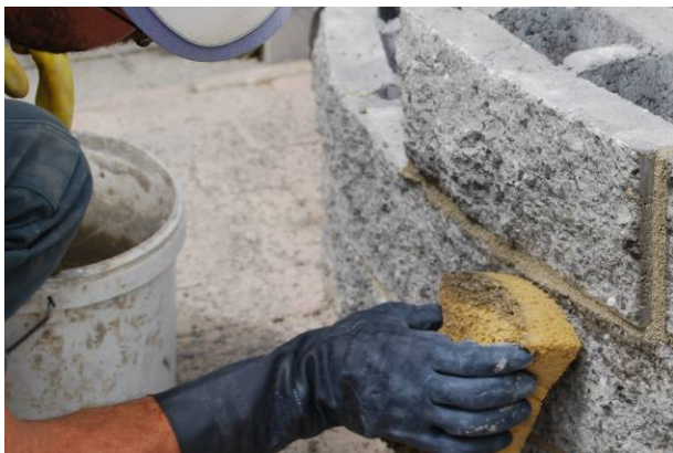
Bild 58: Ausbildung der Mörtelfugen und Reinigung der Mauersteine
