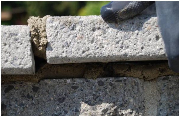
Bild 63: Versetzen der Abdeckplatten
