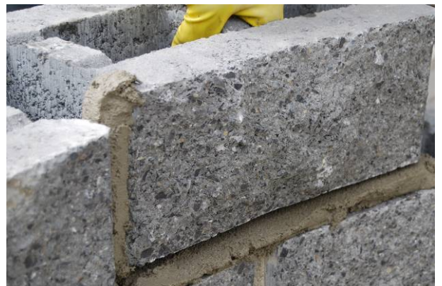
Bild 43: Versetzen des Mauersteines auf die Mörtelschicht
