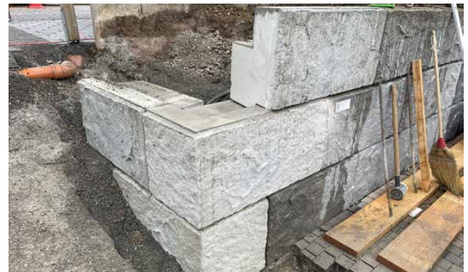
Bild 24 Versetzen der Eckelemente
